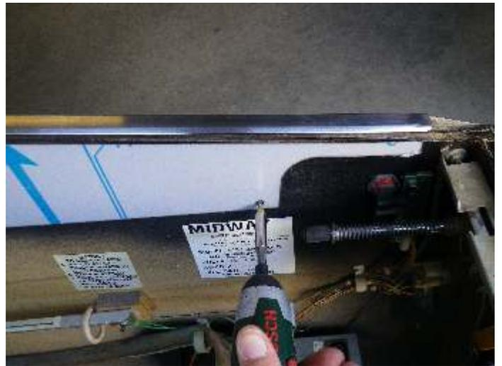
9. Blech ausrichten und Schraube vorne anziehen
